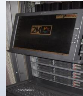
Installation et configuration du matériel et du logiciel ( solution HMS )
