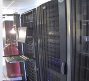
Montage des racks et installation du matériels
